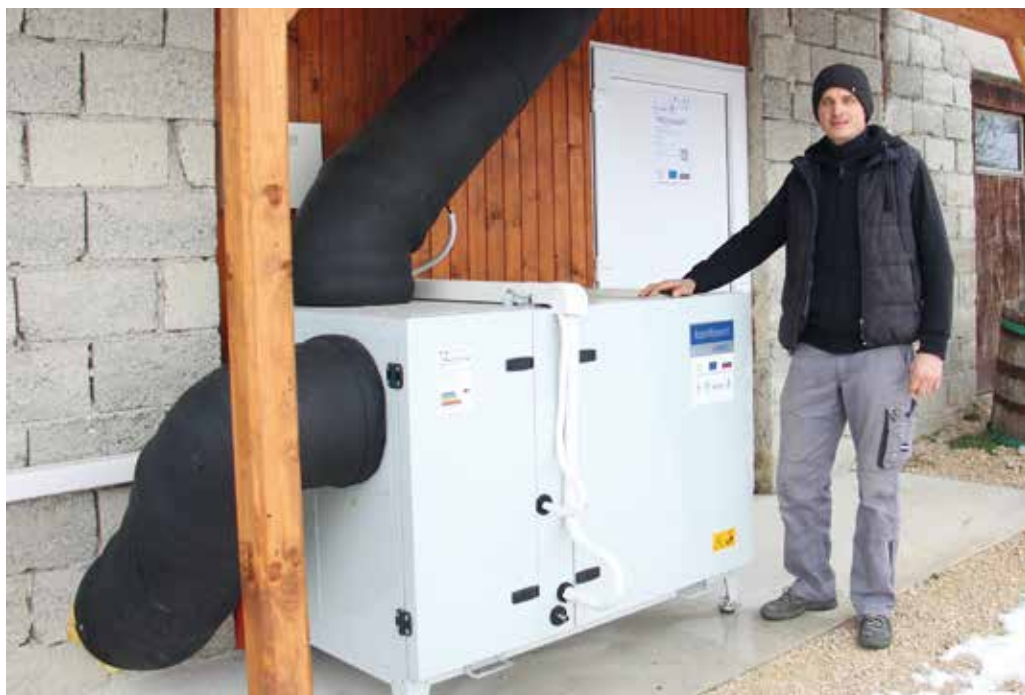
Srce gobarne je prezračevalna naprava za doseganje optimalne klime v gobarni.
