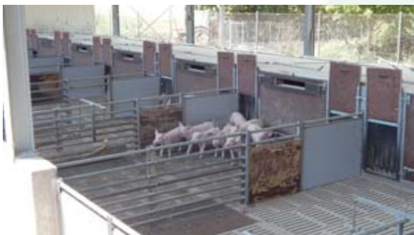
Slika 8: Primer vzrejališča za pujske v obliki odprtega hleva z toplotno izoliranimi ležalnimi nišami in tekališčem z rešetkastimi tlemi.
