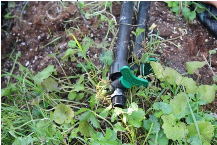
Ventili na koncu cevi
